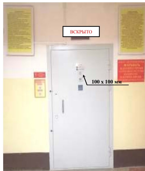
Рис.5 Оборудование КХО смотровым окном
